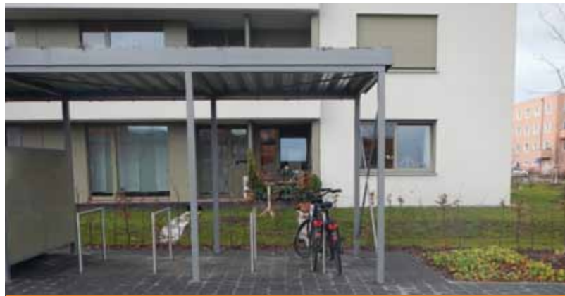
Bild 39: Überdachte Abstellplätze für kurzfristig abgestellte Fahrräder von Besucher/-innen und Bewohner/-innen
