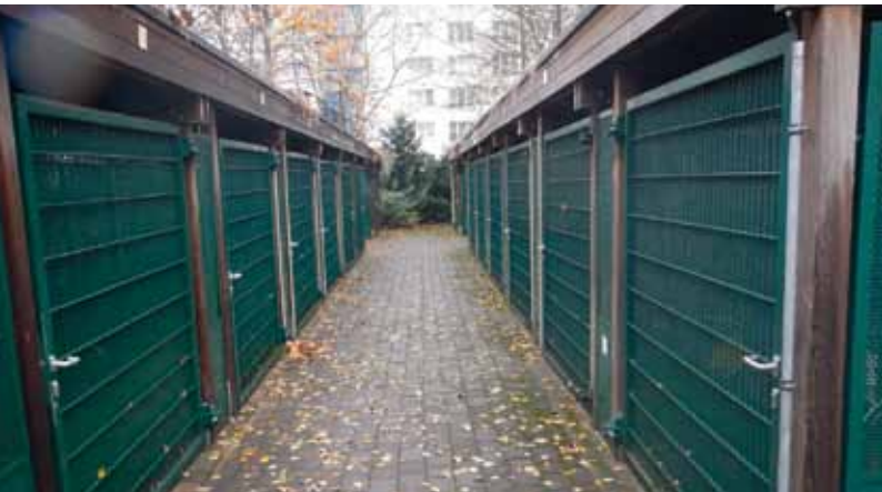
Bild 29: Fahrradkleingaragen in Sammelanlage
