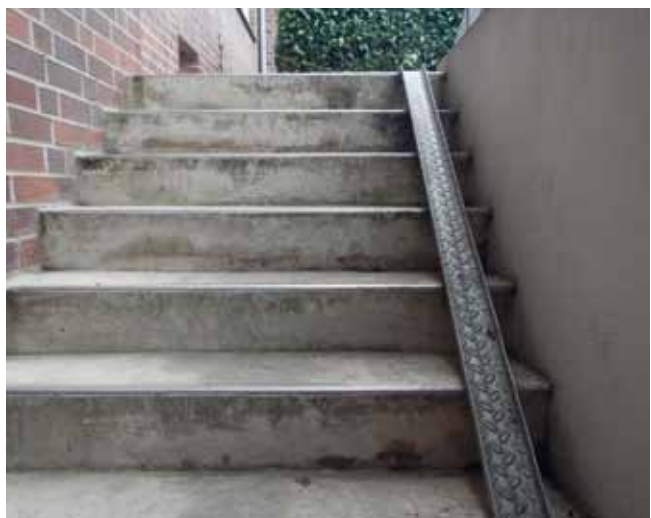
Bild 17: Treppe mit Schieberille
