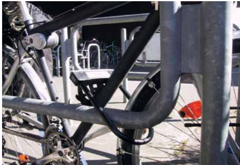
Bild 4: Beispiel eines Anlehnbügels mit Unterholm (Bild: Landeshauptstadt Kiel)
