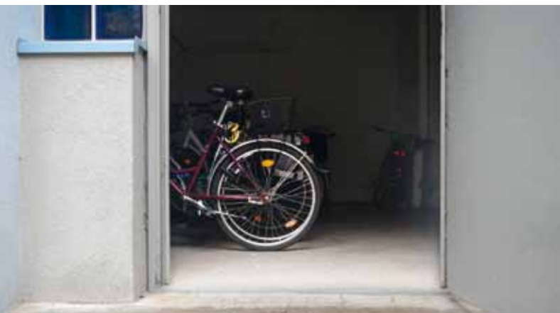
Bild 21: Zugang zu den Abstellräumen
