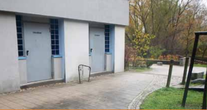
Bild 20: Ebenerdige Abstellräume in ehemalige Müllschlucker-Räumen eines Hochhauses
