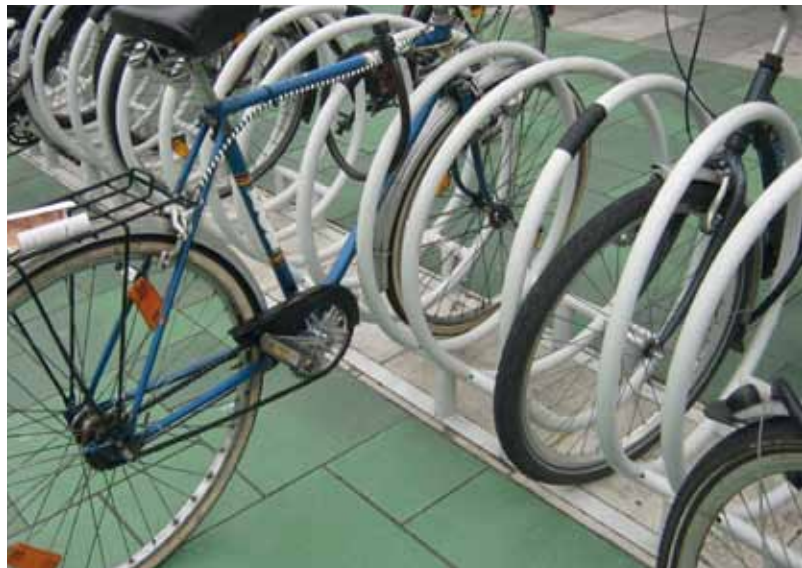
Bild 5: Beispiel eines Anlehnringes mit Wegrollsicherung und flacher Montagेशchiene (Hoch-Tief-Aufstellung)
