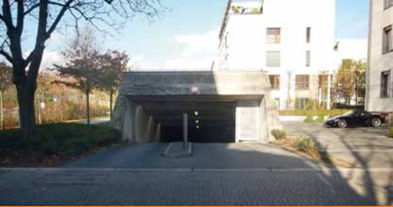
Bild 40: Zufahrt zu der Tiefgarage eines neuen Wohngebäudes in offener Bauweise
