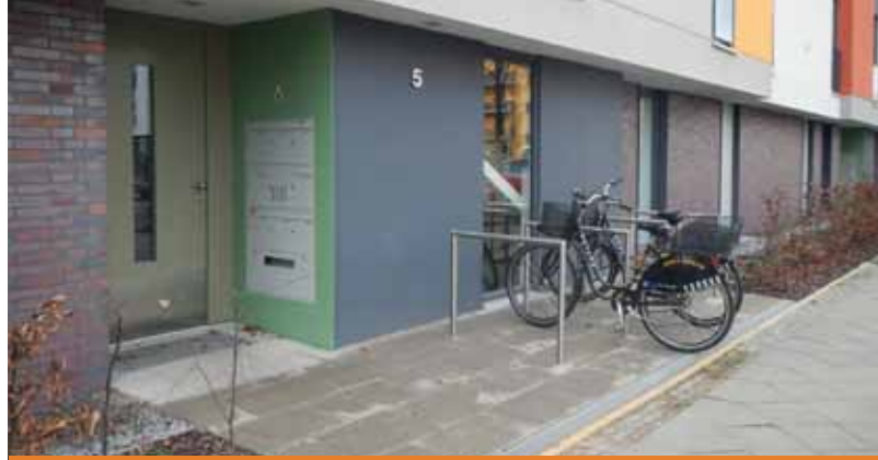
Bild 38: Offene Abstellplätze für kurzfristig abgestellte Fahrräder von Besucher/-innen und Bewohner/-innen neben dem Eingang
