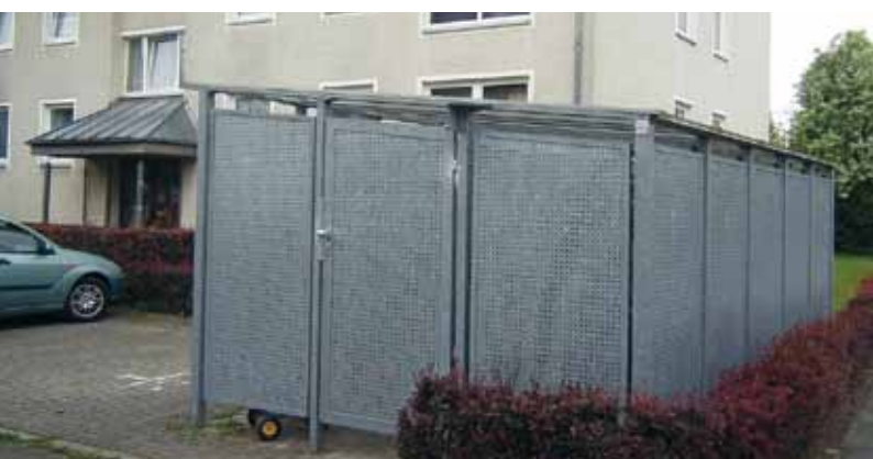
Bild 31: Fahrradkleingarage für Mieter eines Wohnhauses mit sechs Wohnungen
