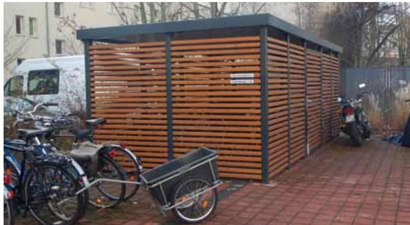
Bild 25: Fahrradkleingaragen im Blockinnenbereich einer Blockrandbebauung
